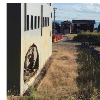
↑裏山が崩落し、土砂や大木で被害を受けた平成蔵の壁。酒造りの期間中は工事ができないため、修復ができません。
