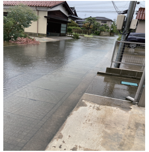
4日午後には小松市を流れる梯川が氾濫し住宅地に流れ込み、床上・床下浸水の被害が報告されました。
