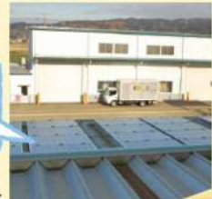
コープいしかわ本部 屋根に設置された太陽光パネル ▶
