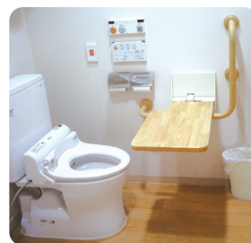
前傾姿勢を支える テーブル型の手すりを設置
